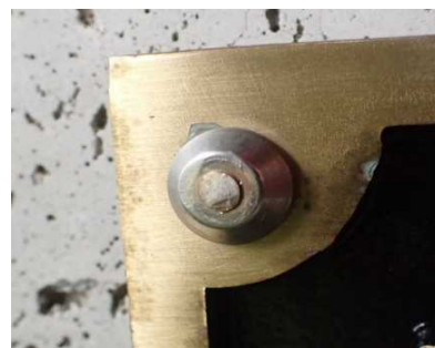
ボルト頭部 目潰し(盗難対策)
