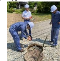
再度災害防止に向けた 被災メカニズム調査（輪島市）
