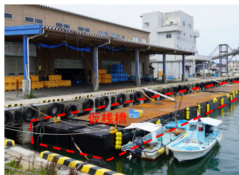
漁船だまり③ 仮棧橋の設置状況
