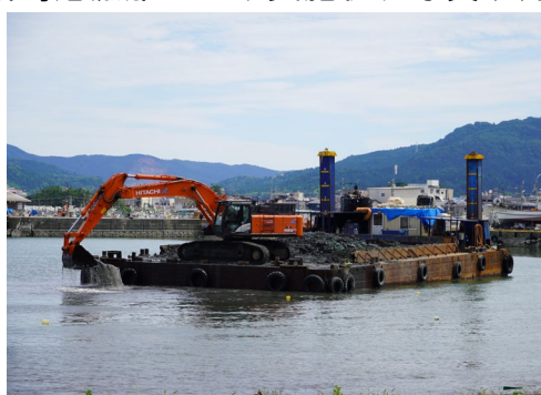
漁船だまり④ 浚渫状況
