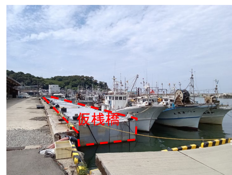
漁船だまり① 仮棧橋の係留状況
