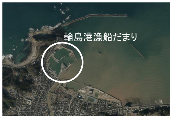
輪島港全体写真
