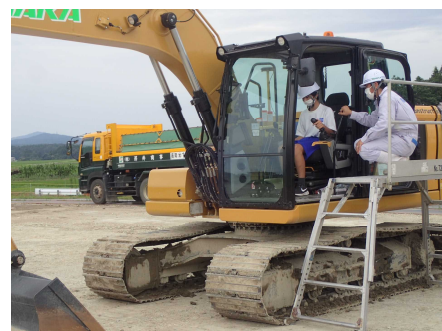
工事現場体験
