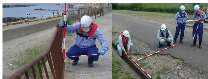
令和5年度の点検状況
