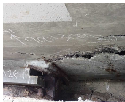
橋の裏面の様子
