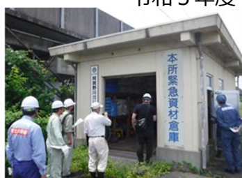
本所緊急資材倉庫 （国土交通省管理）
