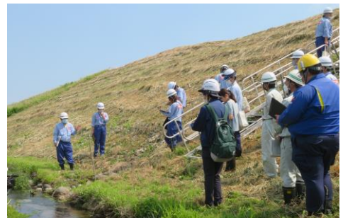
令和5年度 出水期前の合同巡視状況
