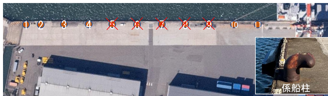
11基の係船柱のうち5基が使用不可
