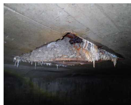
橋の裏面の様子
