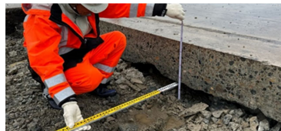
コンクリート舗装版下部の空洞化
