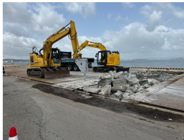
作業② コンクリート舗装撤去
