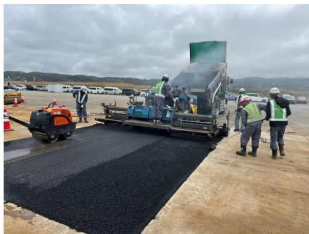
作業⑥ アスファルト舗装敷設
