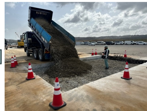
作業④ 路盤材敷均し
