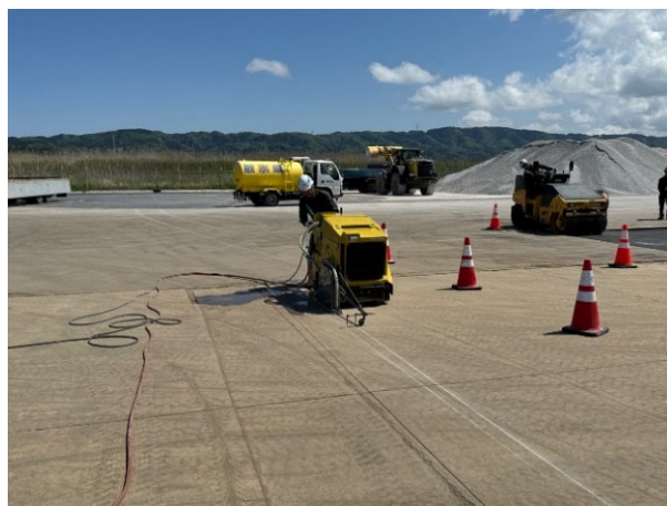
作業① コンクリート舗装カッター 切断
