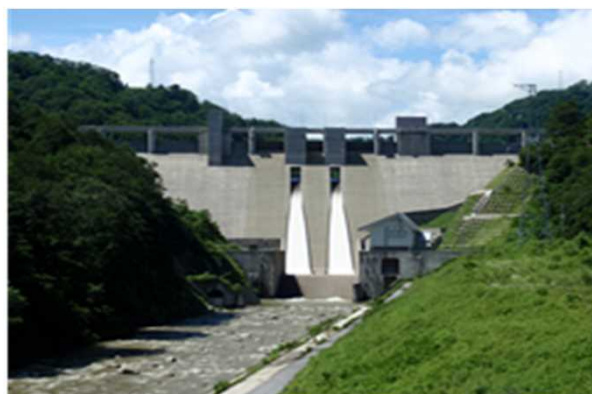
▲オリフィスゲートからの放流 (ダム正面から撮影)
