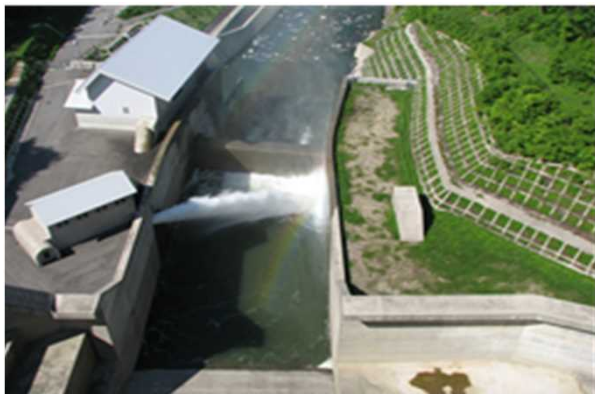
▲利水放流設備からの放流 (ダム天端からの撮影)
