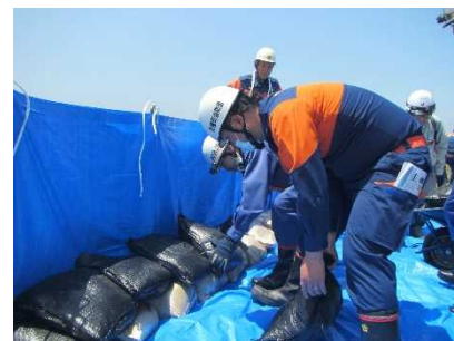
改良積土のう工
