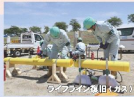
ライフライン復旧（ガス）
