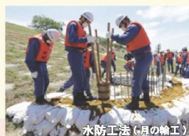
水防工法（月の輪工）
