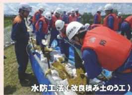
水防工法（改良積み土のう工）
