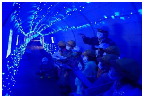
②砂防堰堤監査廊内ライトアップの様子
