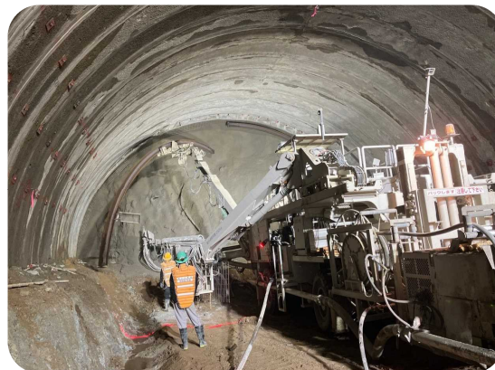
【掘削時の状況】
