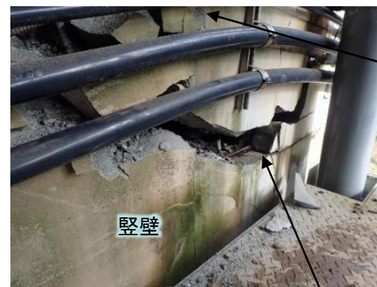
定着部コンクリートの破壊
