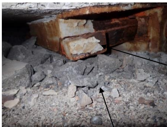
橋座コンクリート破壊、段差
