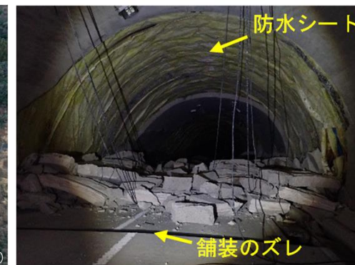
地すべり・斜面崩壊（逢坂トンネル坑口埋没） トンネル覆工崩落・変形（大谷トンネル）
