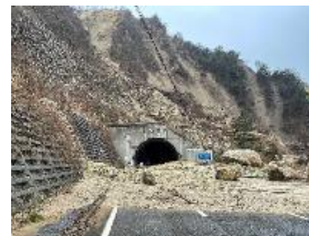
東側（珠洲市側）坑口
