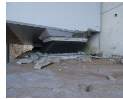
地すべり・斜面崩壊（逢坂トンネル坑口埋没） トンネル覆工崩落・変形（大谷トンネル）
