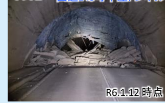
写真① 国道249号中屋トンネル
