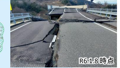
写真④ 国道249号鳥川橋
