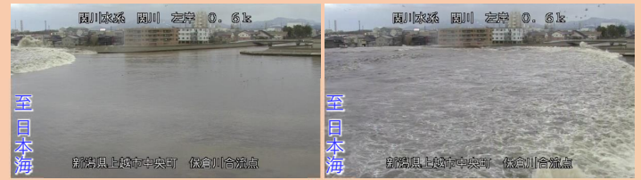
令和6年能登半島地震における関川での津波遡上状況
