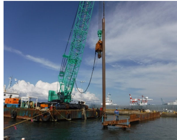
【参考】無量寺岸壁施工時(平成30年10月)
