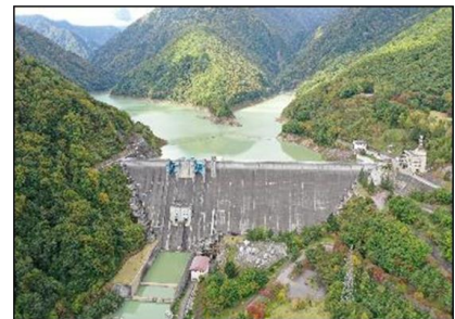
大町ダム（長野県大町市）
