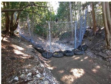
土砂流出防止工の整備イメージ
