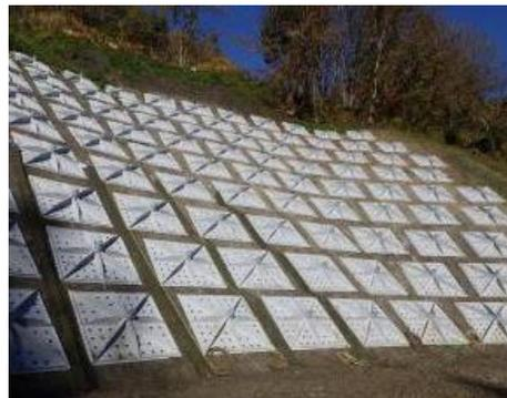
アンカー工(抑止工)の整備イメージ
