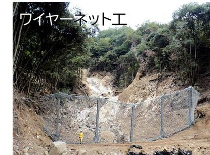
**Step2** 土砂災害が再度発生した場合に発生する土砂・流木に対し、安全性を確保するための砂防施設を設置。(例: 砂防堰堤、流木対策工)
