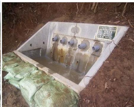
地下水排除工(抑制工)の整備イメージ
