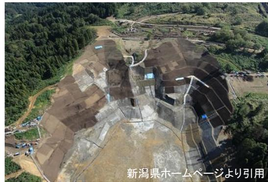
排土工(抑制工)の整備イメージ
