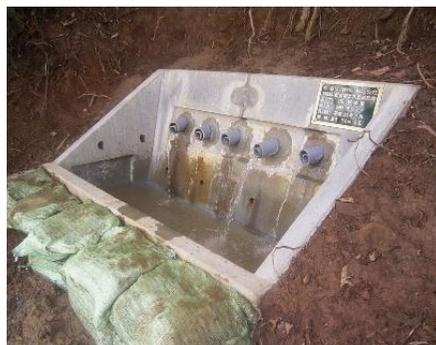
地下水排除工(抑制工)の整備イメージ
