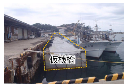
①仮棧橋設置状況(4月23日)
