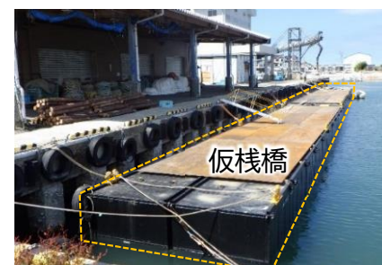
②仮棧橋設置状況(6月26日)
