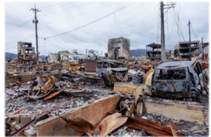
〔輪島市内の火災被害〕
