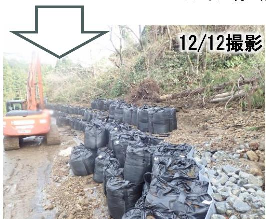
土砂流出に対し、土砂撤去し大型土のう積みを設置
