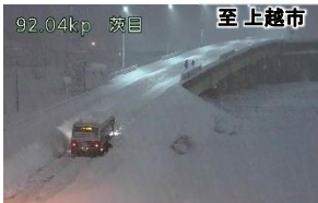
令和4年12月19日 17時頃 国道8号 柏崎高架橋(下) 積雪状況
