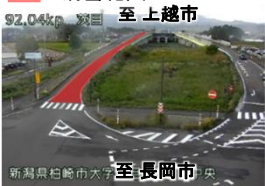
【対応⑤: 除雪効率化】 国道8号 柏崎高架橋(下)に消雪パイプ設置
