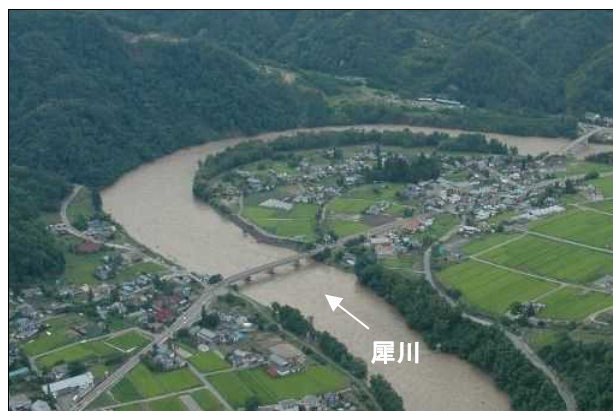
平成18年7月出水時の状況
