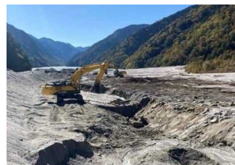
土砂対策設備準備工（掘削）<R6.10撮影>
