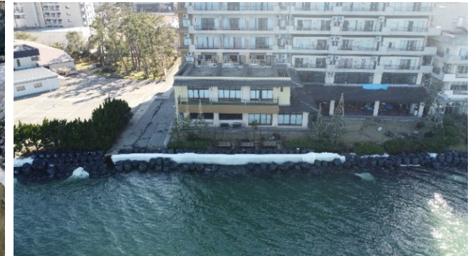
大型土のう設置(応急復旧)
