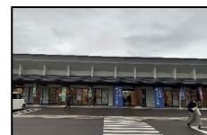
耐震基準に基づく建物・設備
