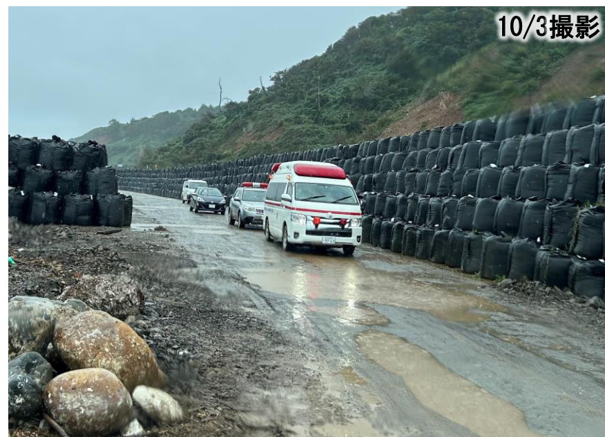
工事用道路の緊急開放
