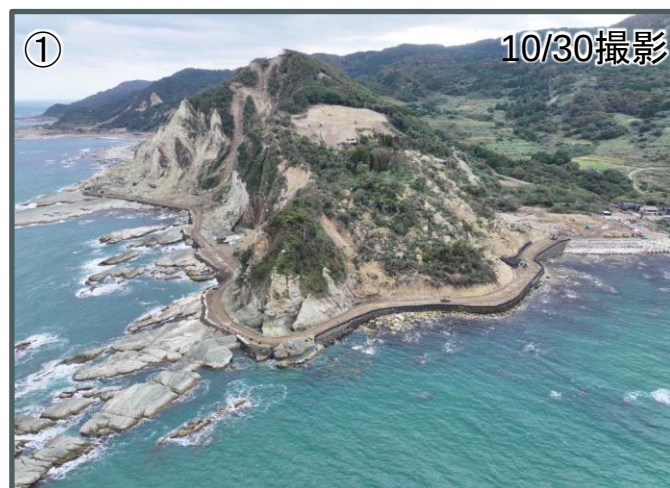
ツバ崎区間全景写真
