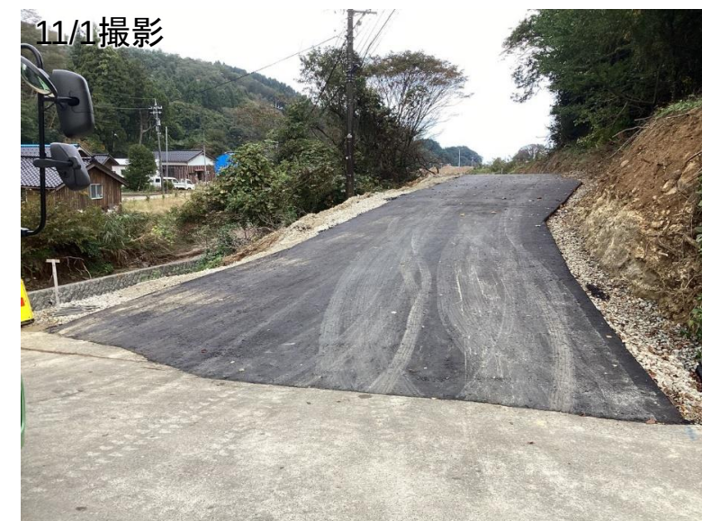
大谷川右岸側迂回路舗装状況
