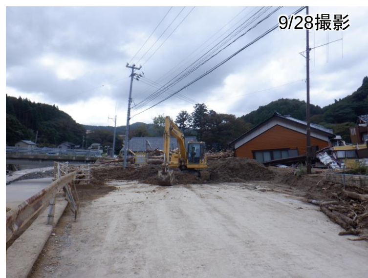
大谷川左岸側道路啓開状況
