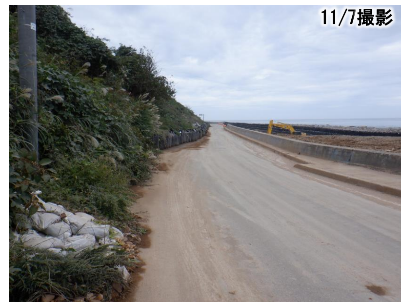
緊急復旧道路(1車線目)の土砂撤去後
