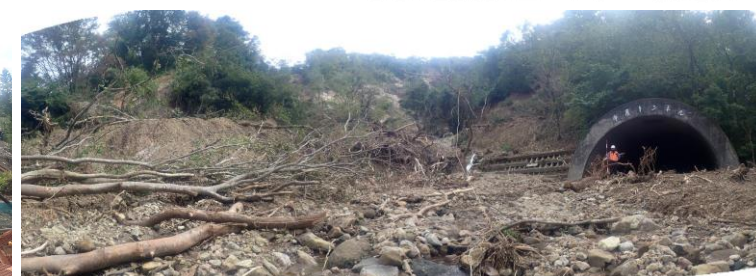
中屋トンネル坑口（輪島側）（9/28撮影）
