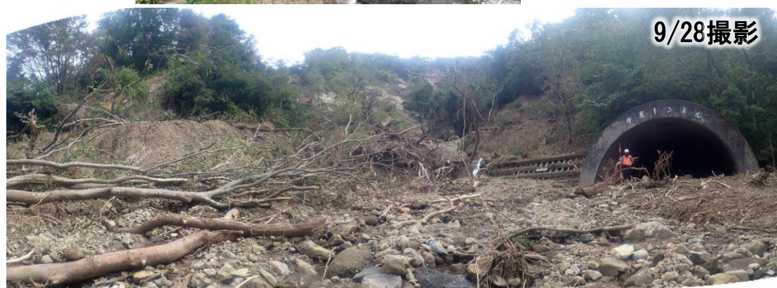
中屋トンネル坑口（輪島側）（9/28撮影）
