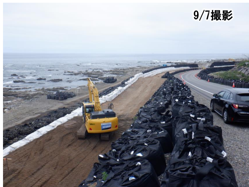
応急復旧道路(2車線目)の施工状況
