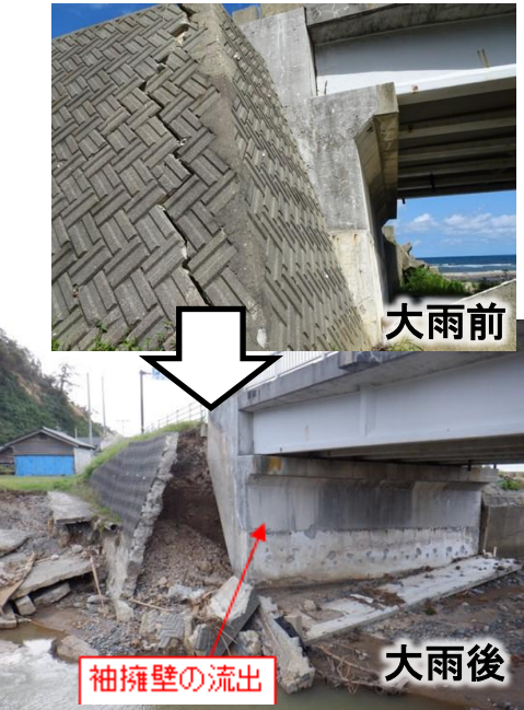
増破した橋台側面部 (輪島市里) 増破した地すべり (珠洲市大谷)
