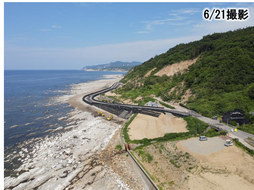
緊急復旧道路(1車線目)の施工状況
