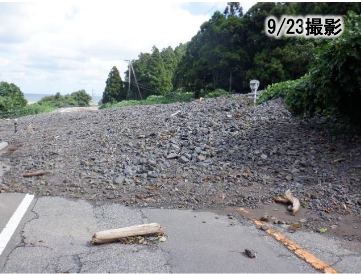
新規に被災した土石流 (輪島市納見)
