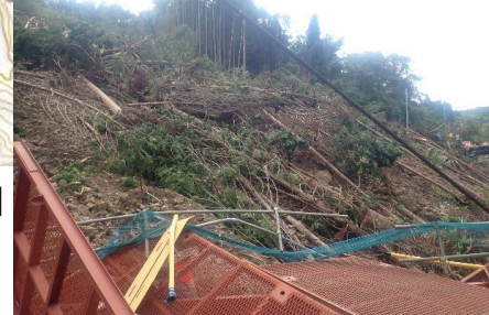
4号仮橋付近（9/28撮影）
