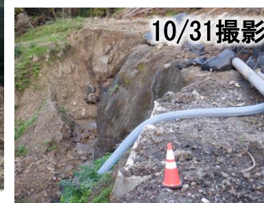
沢水の仮排水
