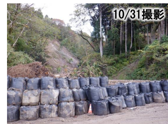
沢出口の大型土のう積み
