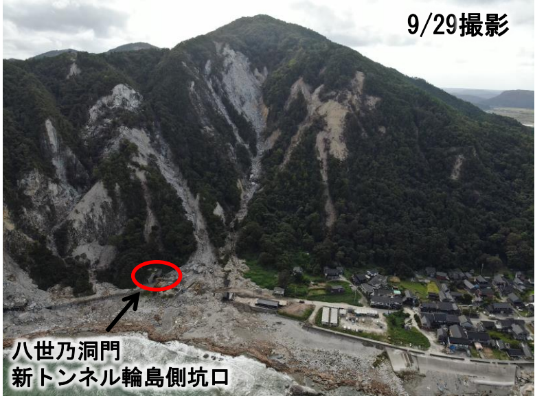
新規に被災した斜面崩壊 (八世乃洞門新トンネル坑口)
