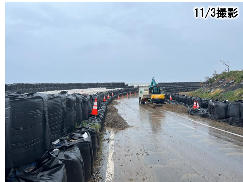
緊急復旧道路(1車線目)の土砂撤去状況
