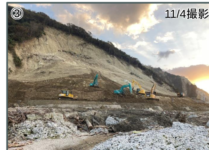
工事用道路造成状況
