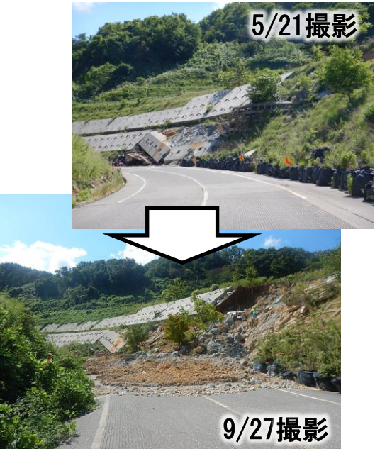
増破した橋台側面部 (輪島市里) 増破した地すべり (珠洲市大谷)
