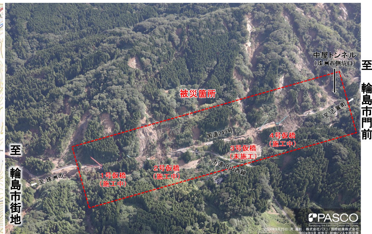
中屋トンネル坑口（輪島側）の斜め写真（9/23撮影）
