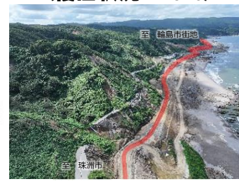
(復旧状況 R6.9)
