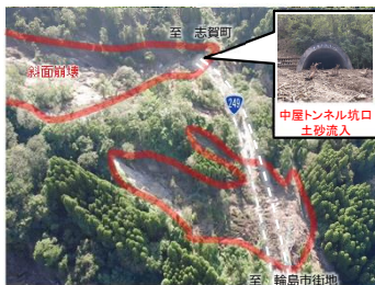
(大雨被災状況 R6.9)
