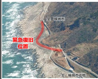
②千枚田工区 (地震被災状況 R6.1)
