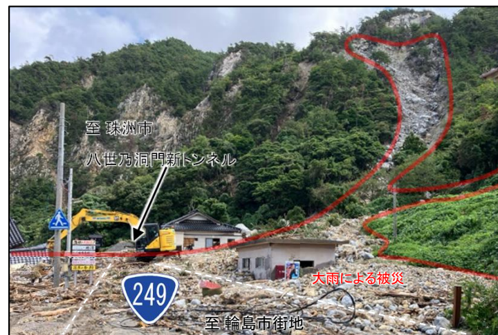
②八世乃洞門新トンネル付近 (輪島市町野町曾々木)
