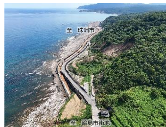
(復旧状況 R6.8)
