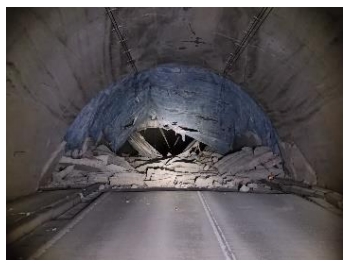
①中屋トンネル工区 (地震被災状況 R6.1)
