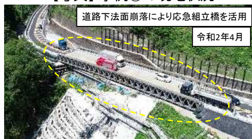
【写真】事例②の現地状況
