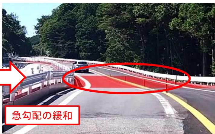
■のと里山海道(穴水IC～徳田大津IC)では、集中工事後もカーブや勾配が急な箇所が残るため、以下の取組も行います。
