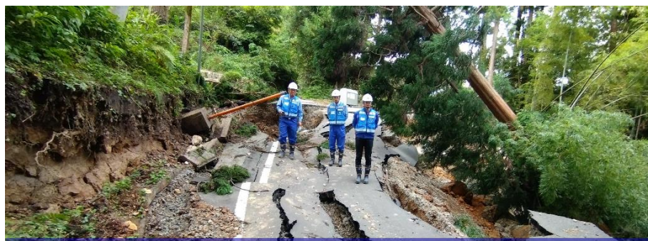
道路啓開班（珠洲市）
