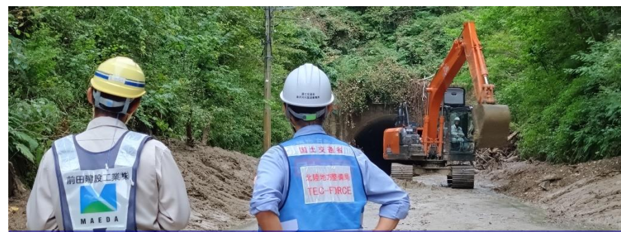
道路啓開班（珠洲市）
