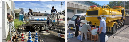
応急給水活動状況
