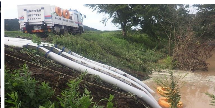
排水ポンプ車派遣（輪島市）
