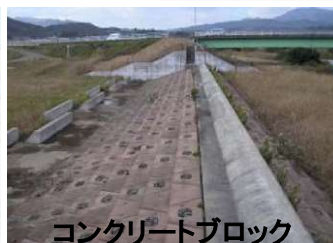
越流堤の構造の例
