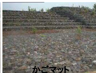
越流堤の構造の例
