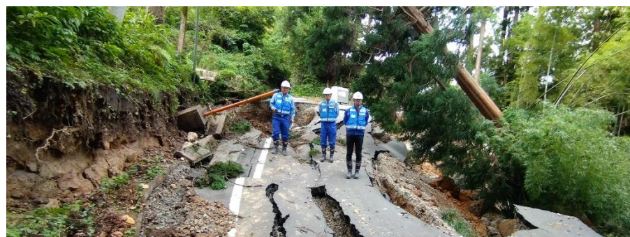
道路啓開班（珠洲市）
