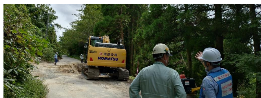
道路啓開班（珠洲市）
