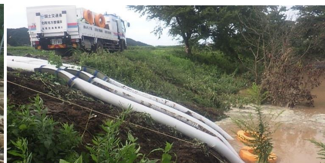
排水ポンプ車派遣（輪島市）
