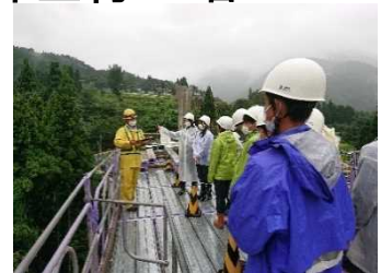
工事現場見学(昨年の状況)
