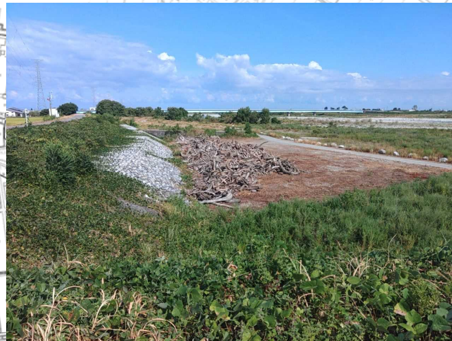
黒部市浦山地先（河口から左岸10.2k付近）
