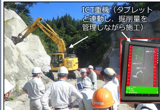
令和5年7月27日に藤沢川第3号砂防堰堤で合同現地見学会を開催し、ICT重機等を活用した砂防工事現場を見学しました
