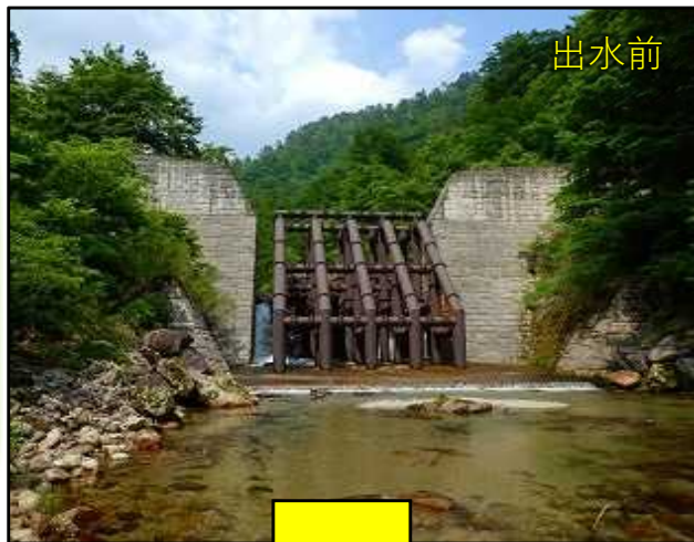
明沢川第3号砂防堰堤
