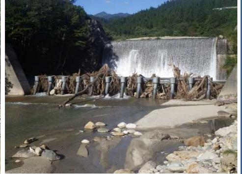
流木を捕捉した穴泷砂防堰堤
