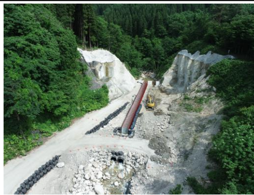
藤沢川第3号砂防堰堤施工状況
