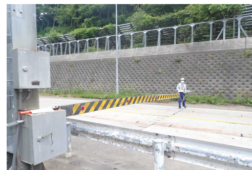
①遮断機を降下完了した状況(福取駐車帯)
