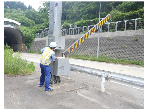
①遮断機の降下作業中(福取駐車帯)
