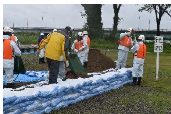
積み土のう工
