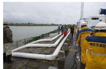
排水ポンプ車訓練
