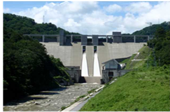
▲オリフィスゲートからの放流(6月10日以降の増水時) ダム正面(展望広場)から撮影
