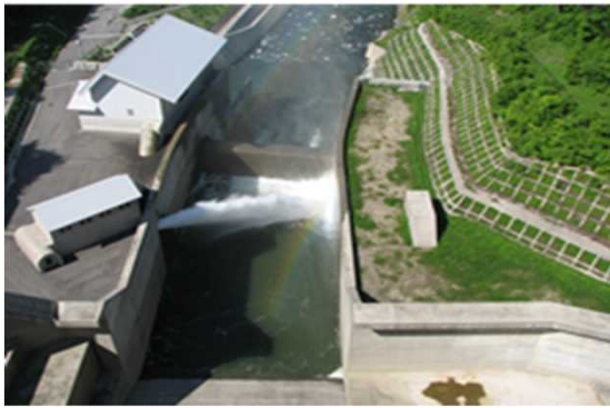
▲利水放流設備からの放流(通常時) ダム天端からの撮影
