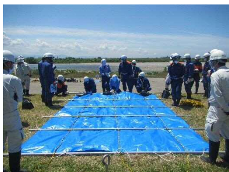
シート張り工
