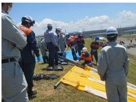
水防マット工
