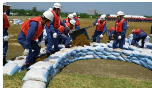
水防工法(月の輪工法)
