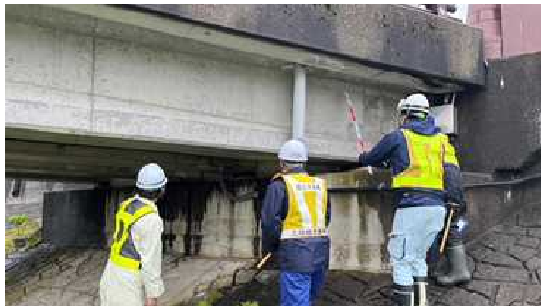
橋梁調査 橋梁点検状況(珠洲市)
