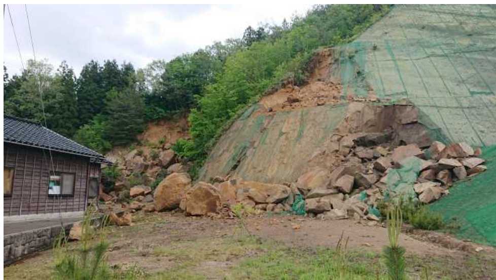
がけ崩れの状況(珠洲市正院町岡田)
