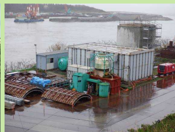
防音ハウスの設置
