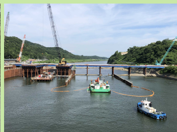
シルトフェンス (汚濁防止膜) の設置
