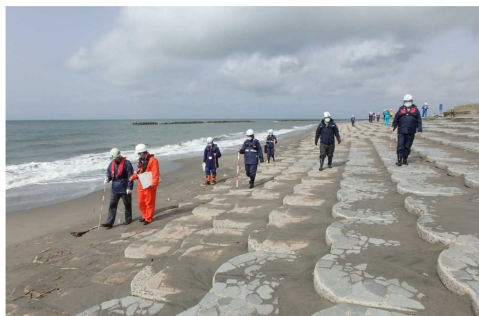
点検の状況(新潟海岸)
